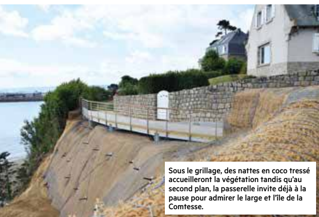
Après la purge des premiers secteurs instables et l'installation de nouvelles canalisations d'eaux pluviales, des pieux de 5 à 7 mètres chacun ont été cloutés dans la partie haute de la paroi pour la consolider. Au total 350 mètres linéaires de forages ont été réalisés.
