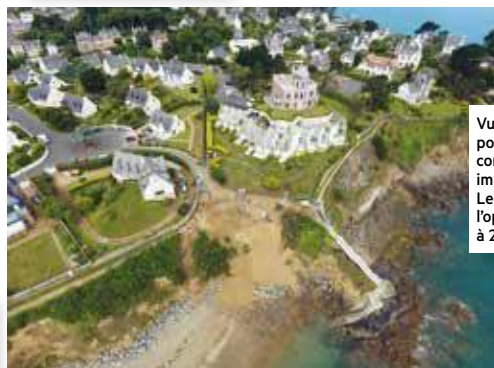
Après la purge des premiers secteurs instables et l'installation de nouvelles canalisations d'eaux pluviales, des pieux de 5 à 7 mètres chacun ont été cloutés dans la partie haute de la paroi pour la consolider. Au total 350 mètres linéaires de forages ont été réalisés.
