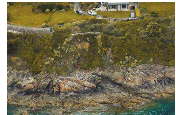
C'est au niveau du renforcement surmonté des barrières Delpierre que le chantier débutera.
