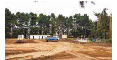
À la place de l'ancienne station, la partie basse du terrain accueillera un parking pour les bus et des espaces végétalisés.
