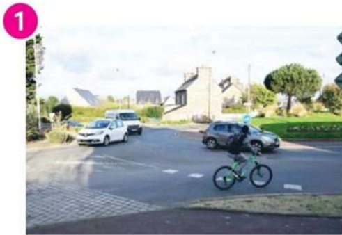
1 Rond-point de la France Libre Réfection complète
